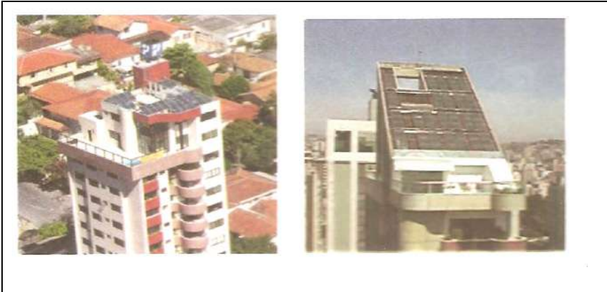
Foto 2- Posicionamento de coletores solares em edifícios Fonte- RODRIGUES; MATAJS, 2010
