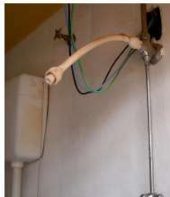
Foto 5- Espera para o chuveiro elétrico e misturador Fonte: (CDHU, 2005a)
