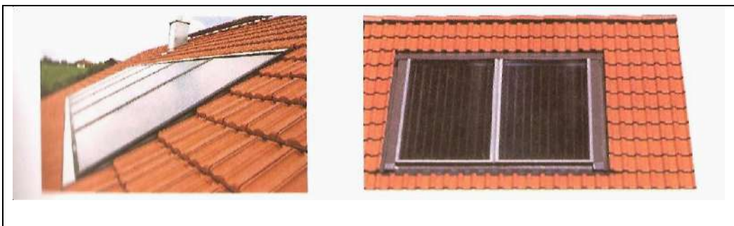
Foto 1 - Alinhamento dos coletores com o telhado
